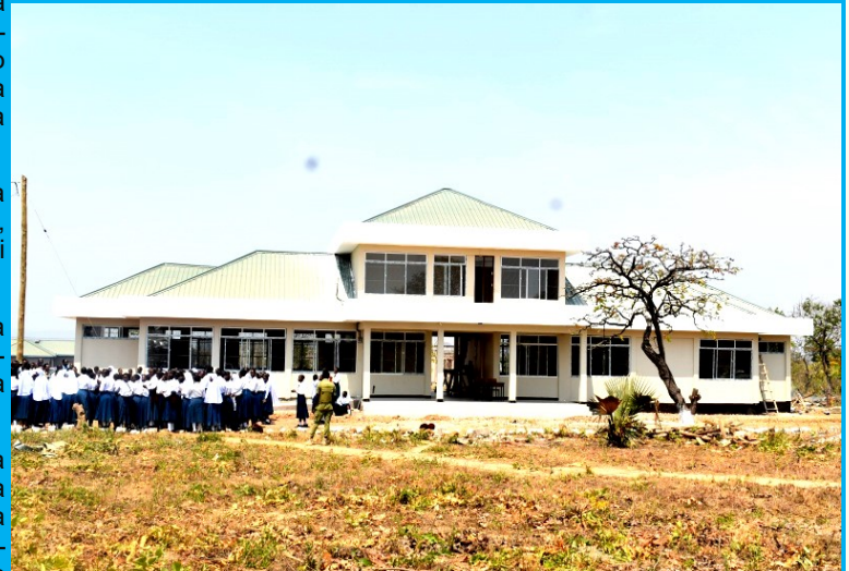
Jengo la Utawala katika Shule ya Sekondari ya Wasichana Kigoma
